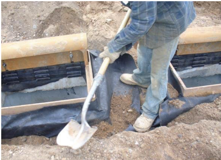
7. Relleno alrededor de la estructura.
