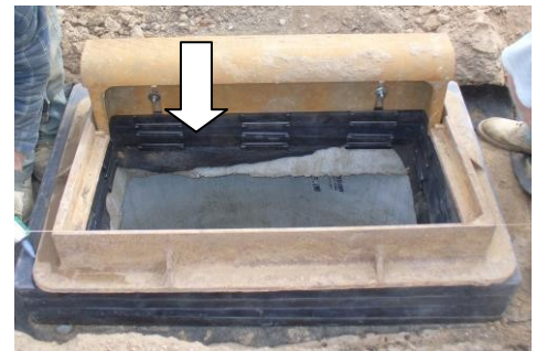
4. Si es necesario desplazar los anillos para lograr la alineación de la colada al bordillo, use una sierra para quitar las lengüetas de bloqueo de la parte inferior del o los anillos según sea necesario. La eliminación de las lengüetas de un lado del extremo del anillo permitirá hasta 2" de desplazamiento. El desplazamiento no debe exceder esta cantidad por anillo. La eliminación de las pestañas de más de un lado permitirá la rotación de los anillos. Nota: El desplazamiento total de todos los anillos no debe exceder los 4" sin que se vierta un collar de concreto para mantener la estabilidad e integridad de la estructura. NOTA: NO SE REQUIERE MATERIAL DE BUTILO entre los anillos
